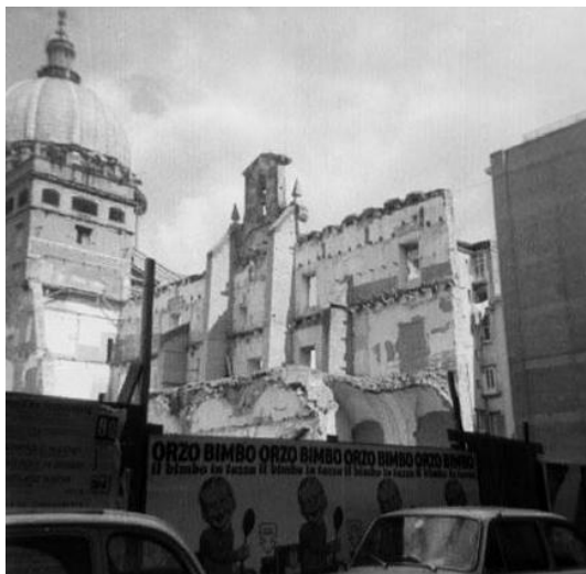
Lavori di demolizione, inizio anni '60_ facciata sud-ovest liberata
