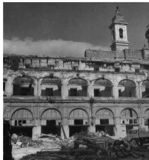
Lavori di demolizione, inizio anni '60_ lato nord
