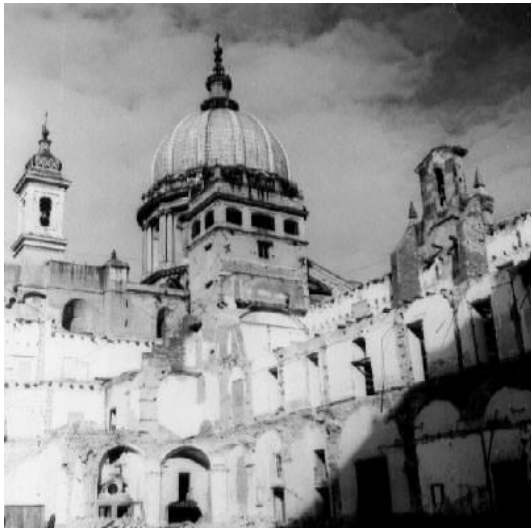
Lavori di demolizione, inizio anni '60_ lato sud-ovest
