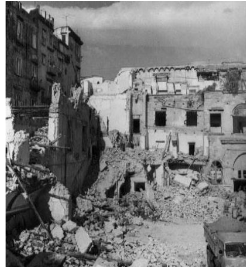
Lavori di demolizione, inizio anni '60_ lato ovest
